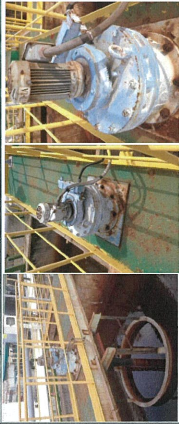
รายละเอียดของ Agitator Brand : Sumitomo Model : CVM5-6135-29
